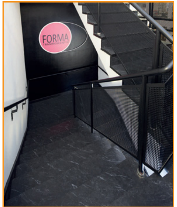
Svart stein i trappehuset på Forma treningscenter.
