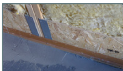
Perfekt for støtte til oppbrett av banemembran for eks Sika Sarnafil. Meget rask montering!
